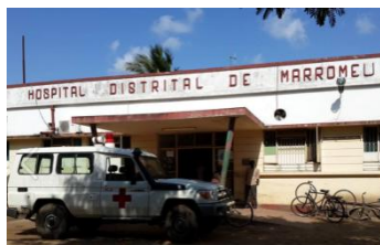
Figura 39 – Hospital Distrital de Marromeu
