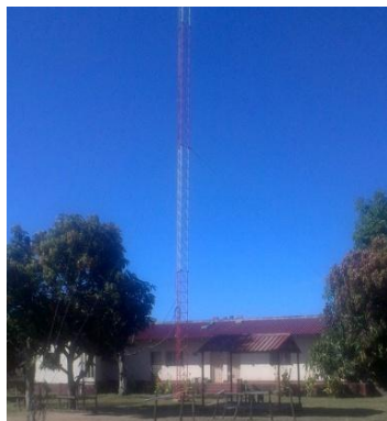
Figura 45 – Instalações da RTVCM em Marromeu
